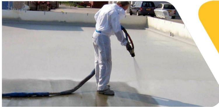
پوشش دهنده سطحی بتن جهت کنترل از تبخیر آب
